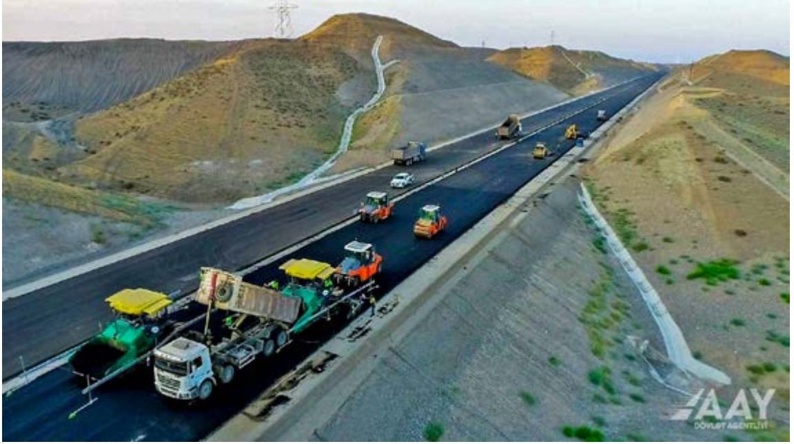
Fotoğraf 8. Zengezur Koridoru'nda Yol Yapım Çalışmaları
